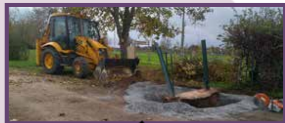
Terrassement portail au stade
