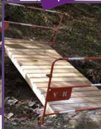
Réalisation d'une passerelle sur la Mouline
