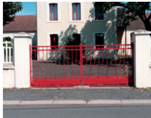
Réfection portail maison des associations
